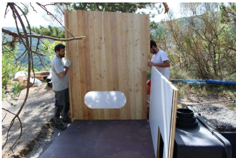
Montaż podpory łączącej kabinę ze zbiornikiem, a następnie z budynkiem
