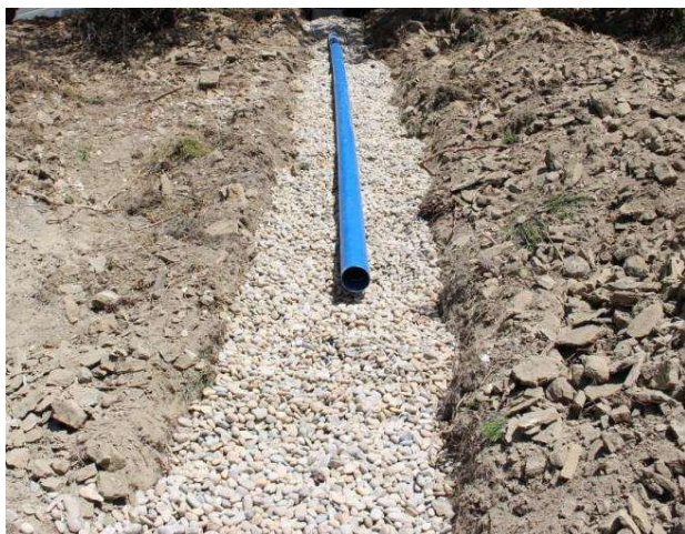
Wykopanie rowu odpływowego
