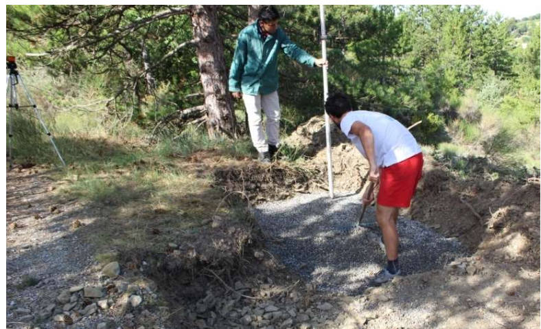
Wykop i wysypanie żwirem
