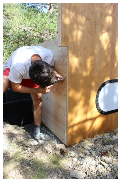
Montaż podpory łączącej kabinę ze zbiornikiem, a następnie z budynkiem
