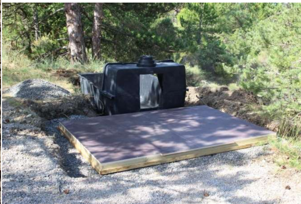
Rozłożenie podłogi i zbiornika
